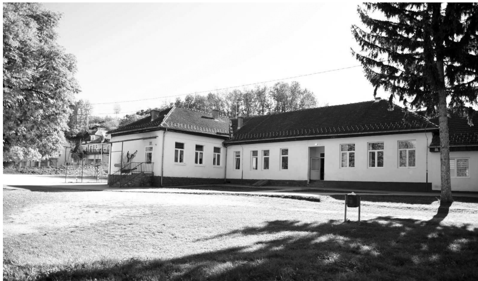
Slika 201 — Centralna školska zgrada
