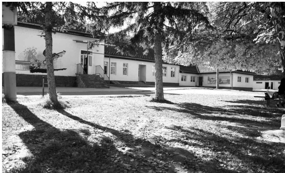
Slika 202 — Centralna školska zgrada
