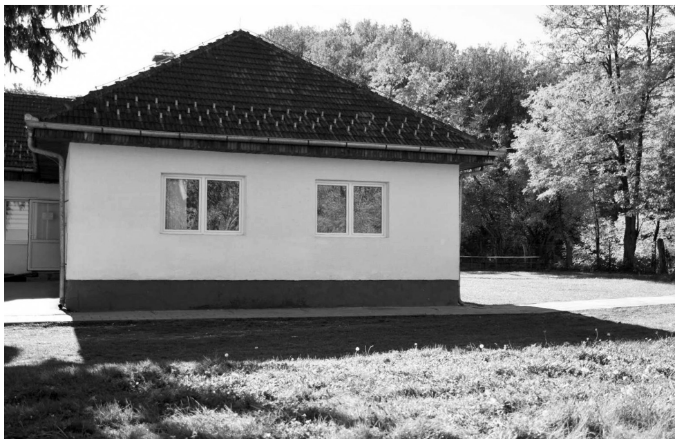
Slika 203 — Centralna školska zgrada
